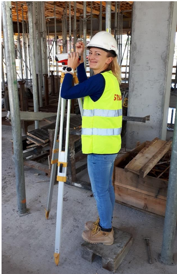
Fot: Martyna Koczy, Inżynier Budowy, źródło: STRABAG
