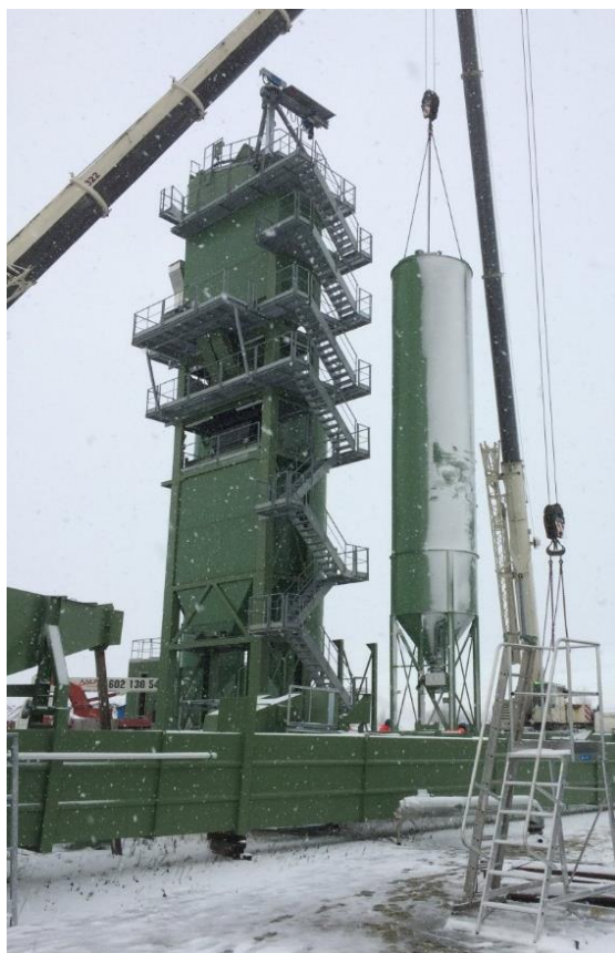
Fot: Montaż WMB, źródło: STRABAG
